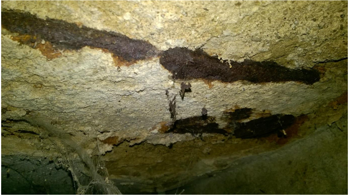
fot. nr 1 korozja powodująca rozwarstwienie dolnych pól belek stropowych
