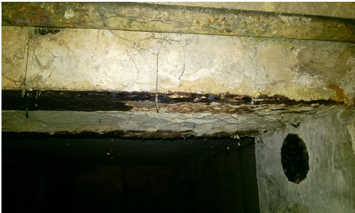
fot. nr 3 skorodowane i rozwarstwione nadproże
